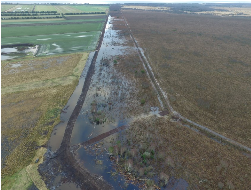
Dæmningen ved nordøst-kanten af Tofte Mose.
